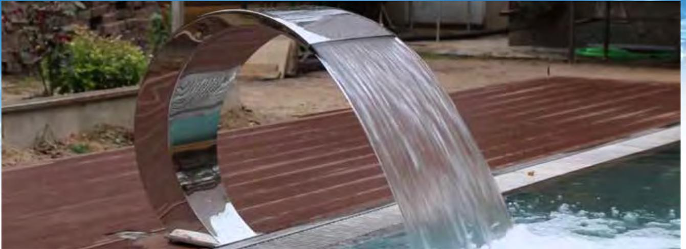
Установку водопада рекомендуется планировать на этапе проектирования и строительства бассейна, так как установка этого аттракциона в готовый бассейн без вмешательства в конструкцию чаши невозможна. Для монтажа обязательно потребуются: излив водопада с закладной деталью, заборник воды, циркуляционный насос, пневмоклапан с пневмошлангом и адаптером, блок пневмопуска.
