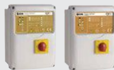
Шкафы управления CDF1, CDF2
