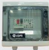
Щит электрический CUADRO ELEC. MONO. 220V с пневмоуправлением
