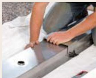
Наложите крепежные элементы из нержавеющей стали и прикрепите с помощью восьми гаек и винтов с шайбами. Переверните желоб в нормальное положение—Вам может понадобится помощь другого человека.
