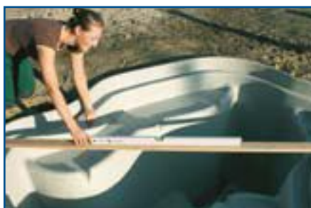
8. Выравнивание Вставьте резервуар в яму и выровняйте его по длине и ширине. Затем заполните его водой на 1/3 от общего объема.
