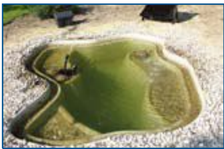
10. Заполнение и выравнивание В конце необходимо выровнять место вокруг пруда с помощью песка, грунта, гравия и т.д.
