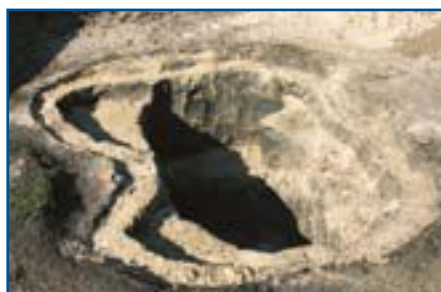
7. Заполнение Выровняйте песком глубину в различных местах, пока готовая яма не будет выглядеть так, как на рисунке.
