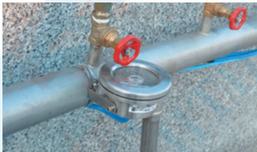
Установка светильника на кольцевом распределителе
